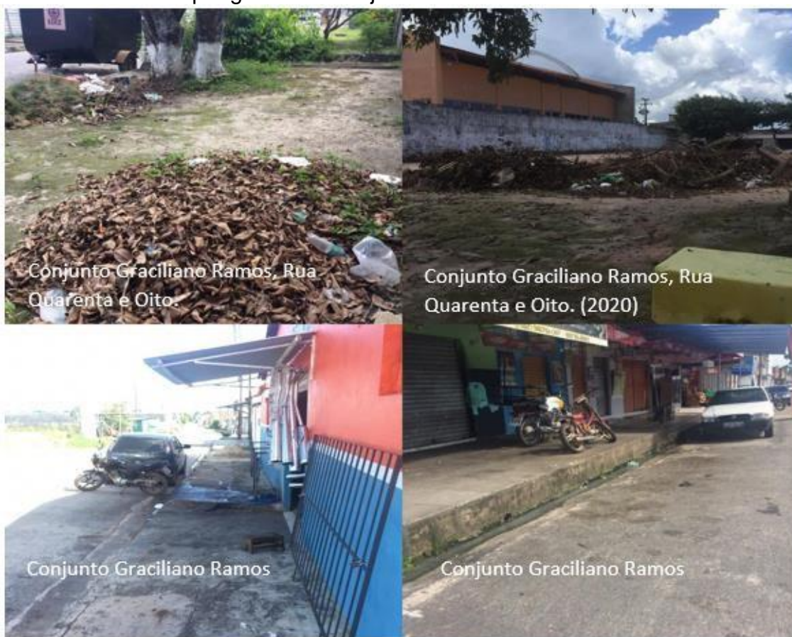
Figura 3 - Entulhos de lixos e podas de árvores e presença de resíduos perigosos no Conjunto Graciliano Ramos.
